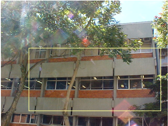
Figura 9. Vista externa da sala de aula CTC 208.
