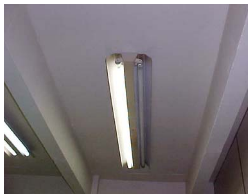
Figura 22. Exemplo de Iluminação utilizado em 12% das Salas Administrativa da UFSC - CCS
