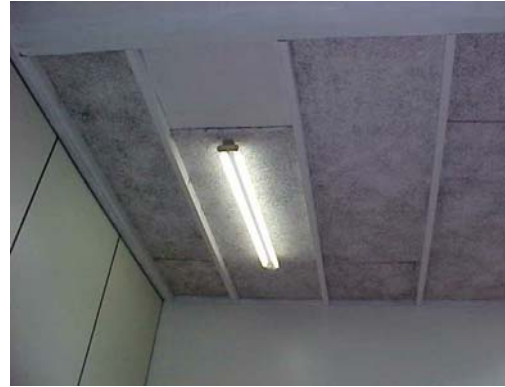
Figura 31. Sala de aula do CDS
