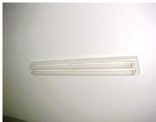
Figura 27. Exemplo de Suporte para lâmpadas utilizado em 81% das Salas de Professores da UFSC - Colégio de Aplicação
