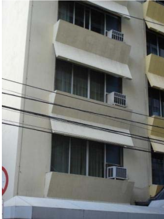
Figura 4. Proteções solares na janela.
